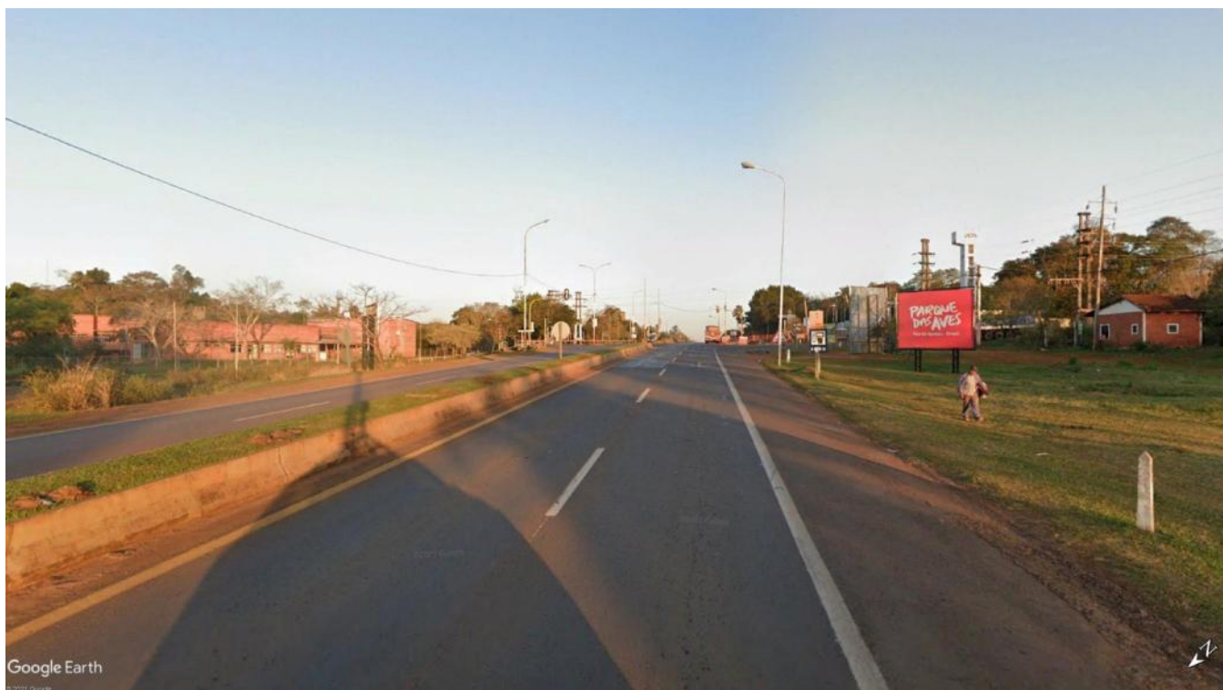
Imagen 10.2 – Vista de RN N° 12 Km 1.638,60 (hacia el Sureste)
