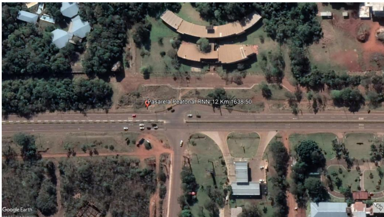
Imagen 2.3 – Imagen Aérea del sector donde se ubica la Pasarela Peatonal (RNN°12 Km 1638,50)
