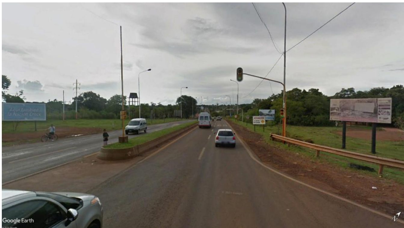
Imagen 10.1 – Vista de RN N° 12 Km 1.638,60 (hacia el Noroeste)
