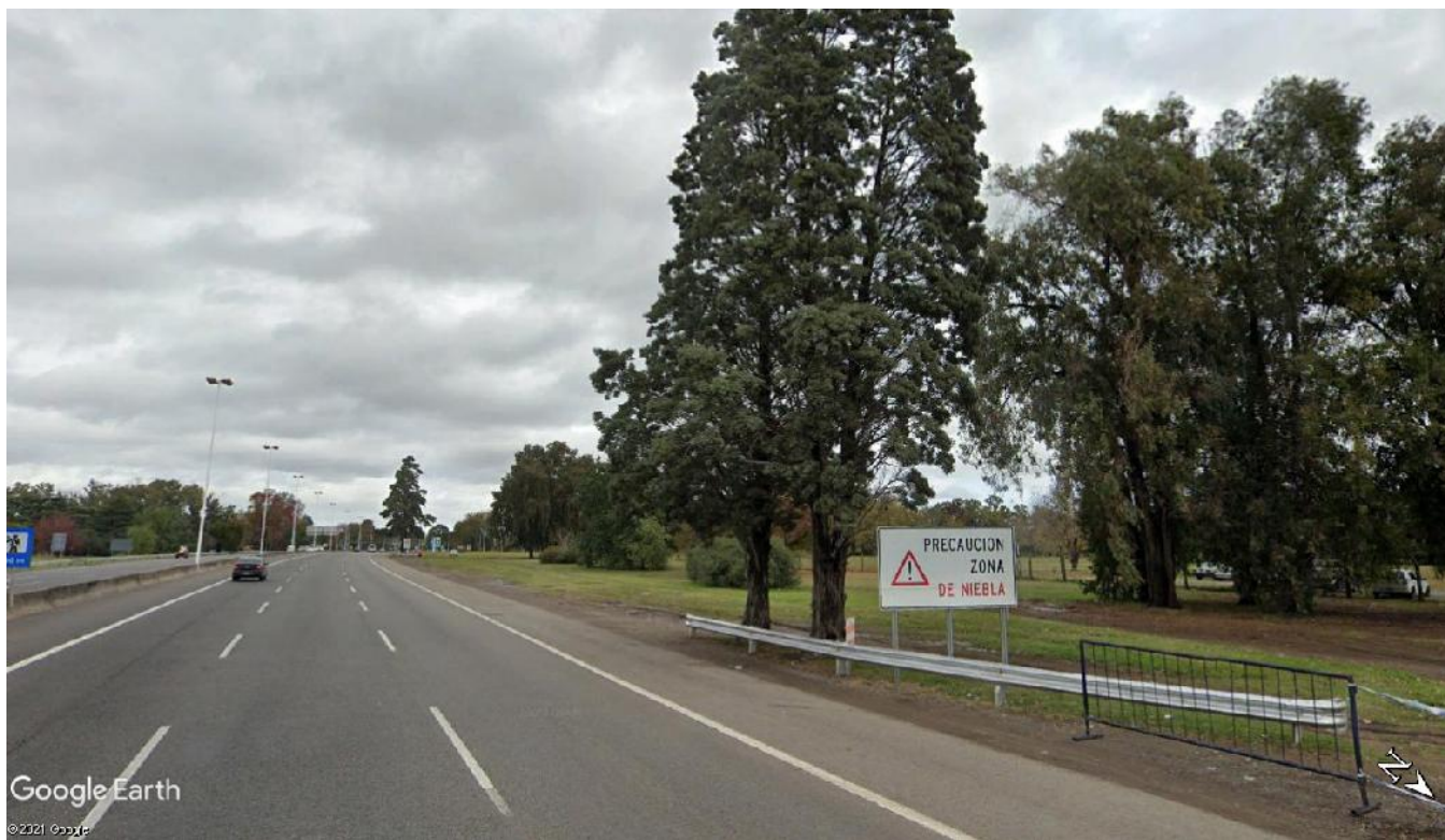
Imagen 10.1 – Vista de defensa metálica, árboles y señalización vertical a retirar (Lado Ascendente)
