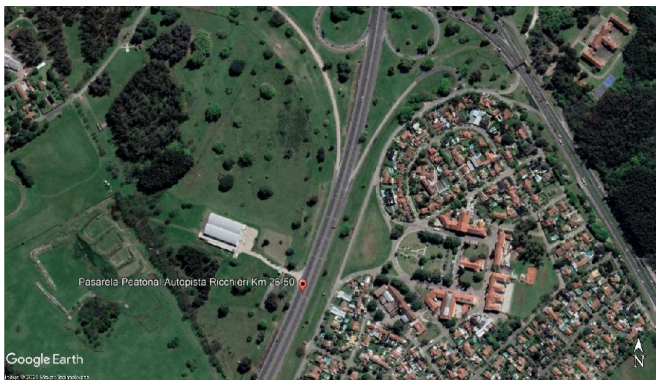
Imagen 2.3 – Imagen Aérea del sector de ubicación de la Pasarela Peatonal (Au. Ricchieri Km 26,50)
