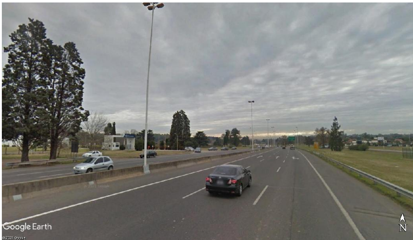
Imagen 10.3 – Vista de ubicación de Pasarela Peatonal a construir (hacia el Norte)
