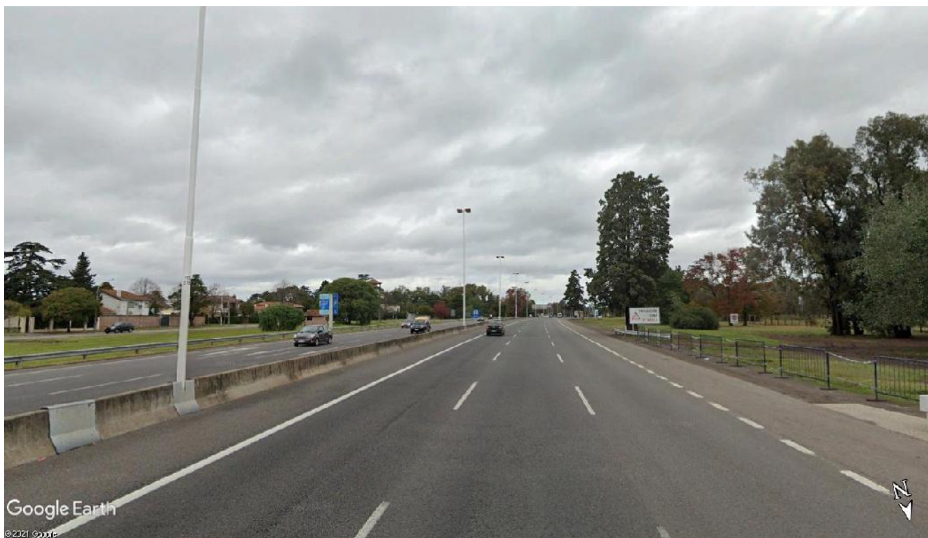
Imagen 10.2 – Vista de ubicación de Pasarela Peatonal a construir (hacia el Sur)
