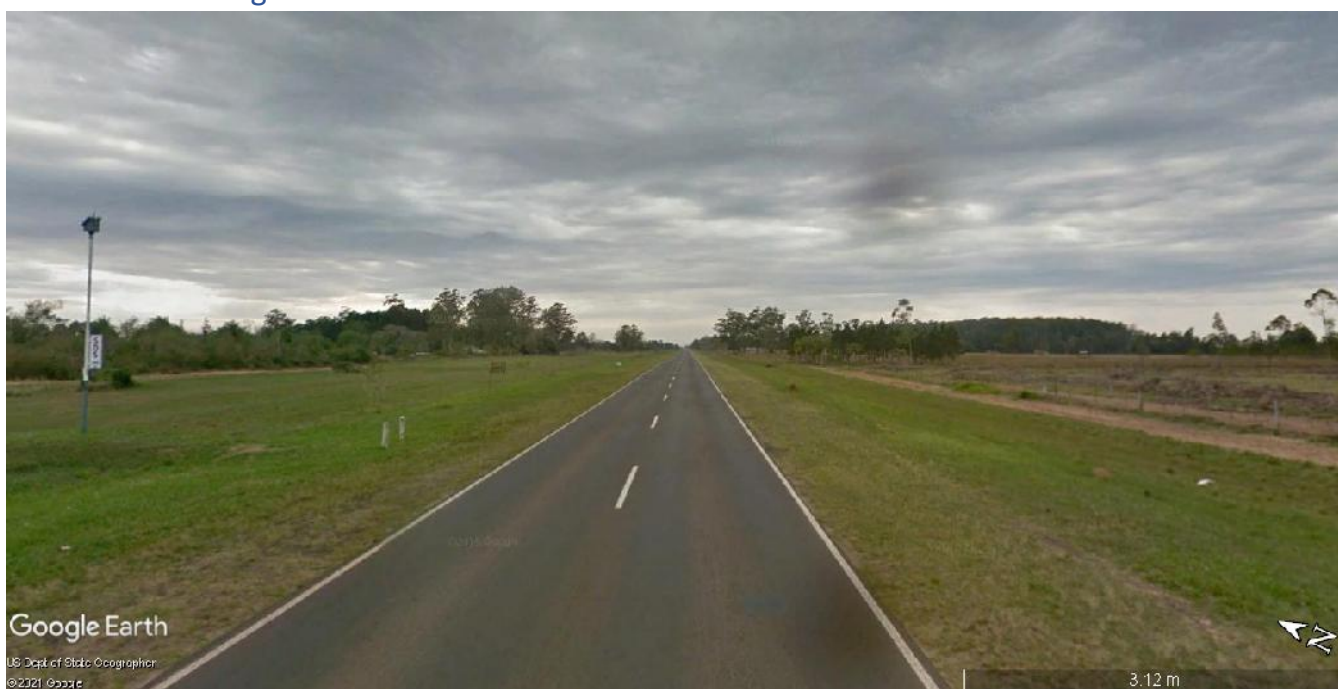
Imagen 3.1 – Vista de Banquinas RN N°12 Km 1250,00 hacia el Noreste
