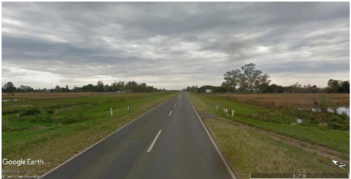
Imagen 3.4 – Vista de Banquinas RN N°12 Km 1253,00 hacia el Noreste (se visualiza alcantarilla)
