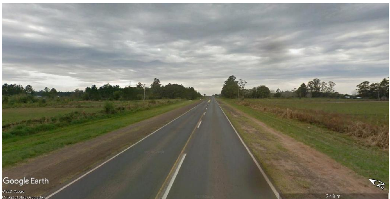
Imagen 3.3 – Vista de Banquinas RN N°12 Km 1252,00 hacia el Noreste
