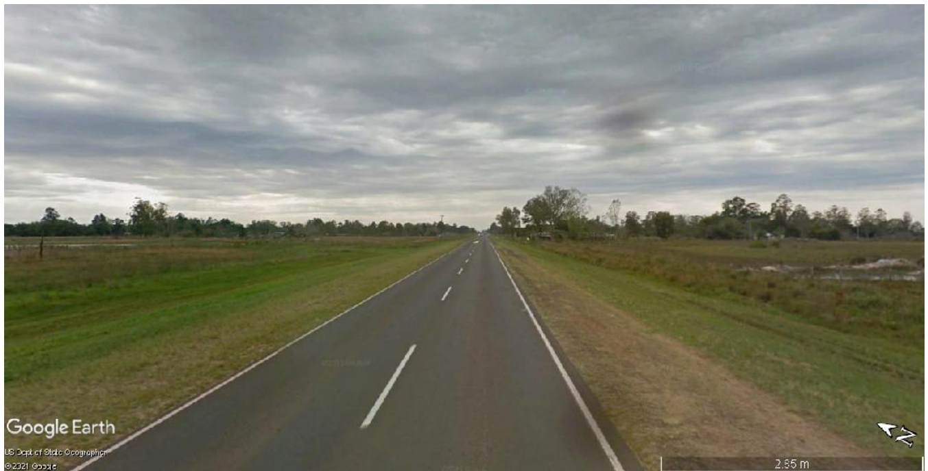
Imagen 3.2 – Vista de Banquinas RN N°12 Km 1251,00 hacia el Noreste
