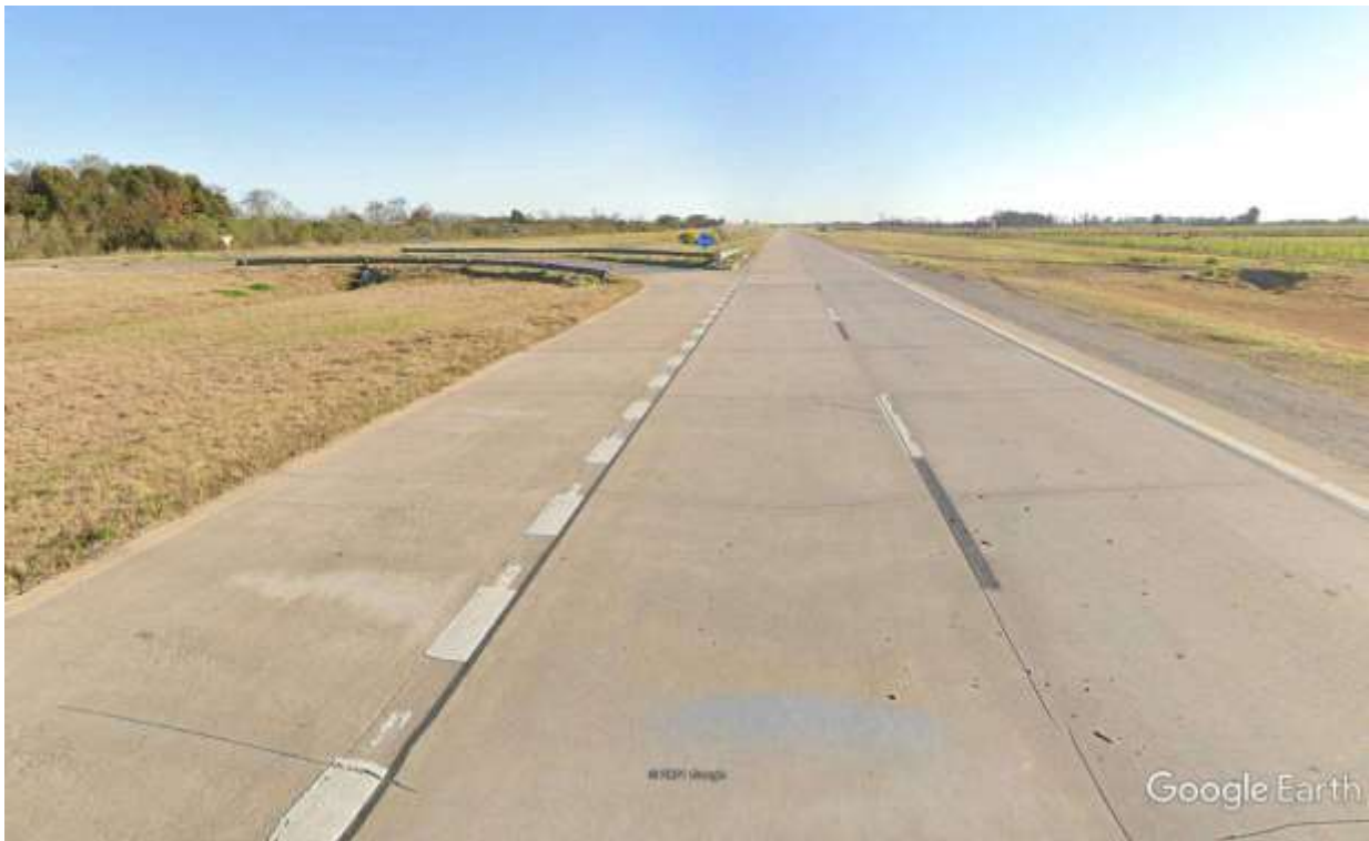
Imagen 13: Calzada Ascendente - Fin de Retorno Vial (Vista Este - Oeste)
