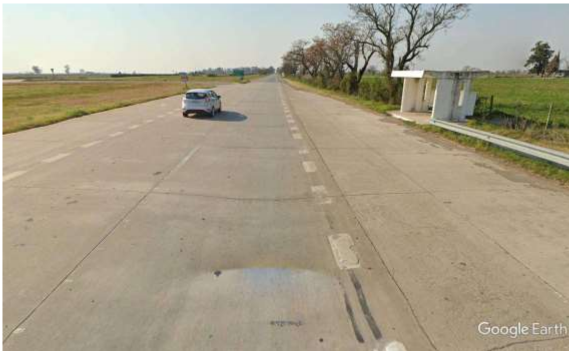
Imagen 7: Calzada Descendente - Parada de Autobús y Refugio (Vista Oeste- Este)
