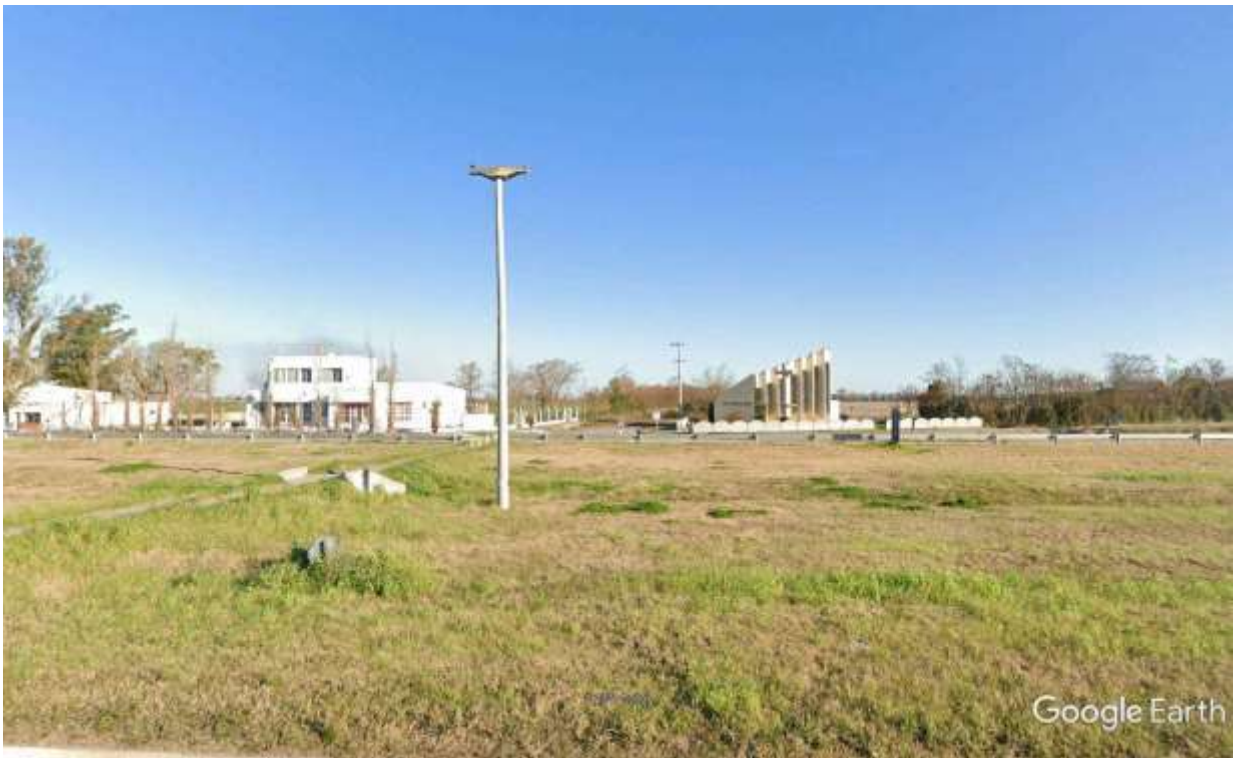
Imagen 11: Cruce de Línea de Media Tensión (Vista Norte - Sur)
