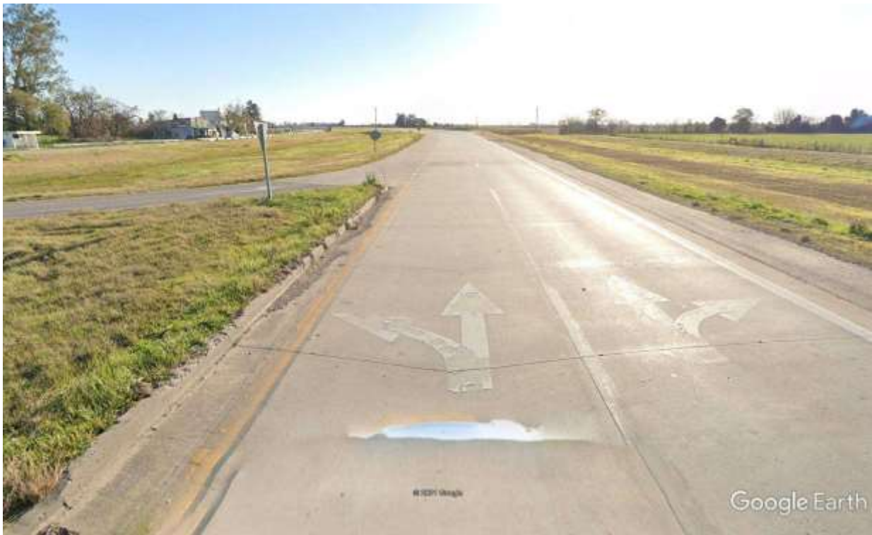
Imagen 9: Calzada Ascendente - Inicio de Retorno (Vista Este - Oeste)
