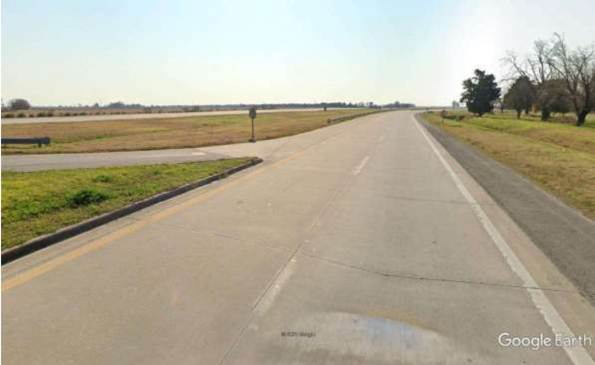
Imagen 4: Calzada Descendente - Inicio de Retorno Vial (Vista Oeste - Este)
