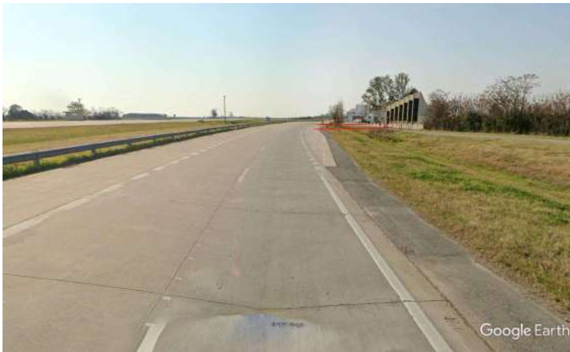
Imagen 5: Calzada Descendente - Inicio de Acceso Vial (Vista Oeste-Este)
