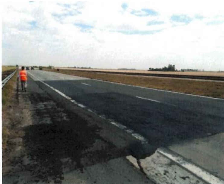
FOTO 1. BACHEO CON MEZCLA BITUMINOSA
