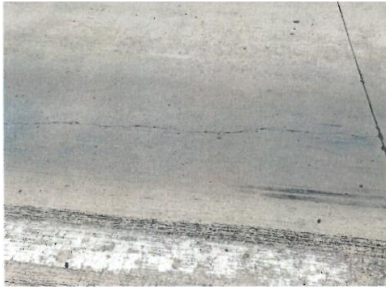
FOTO 4. FISURA LONGITUDINAL
