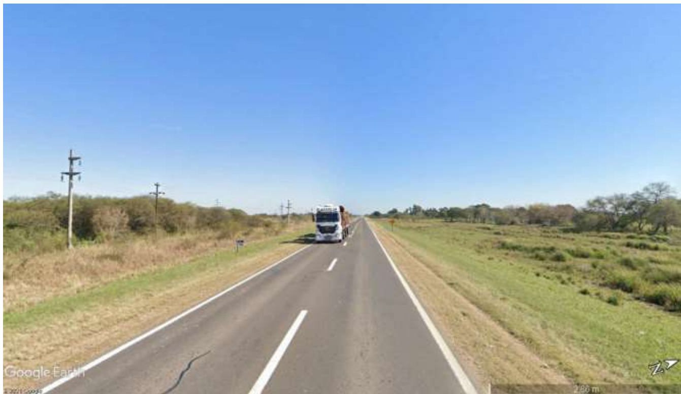
Imagen 3.1 – Vista de Banquinas RN N°16 Km 168,00 hacia el Noroeste
