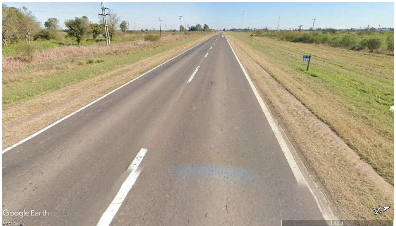
Imagen 3.2 – Vista de Banquinas RN N°16 Km 171,00 hacia el Noroeste
