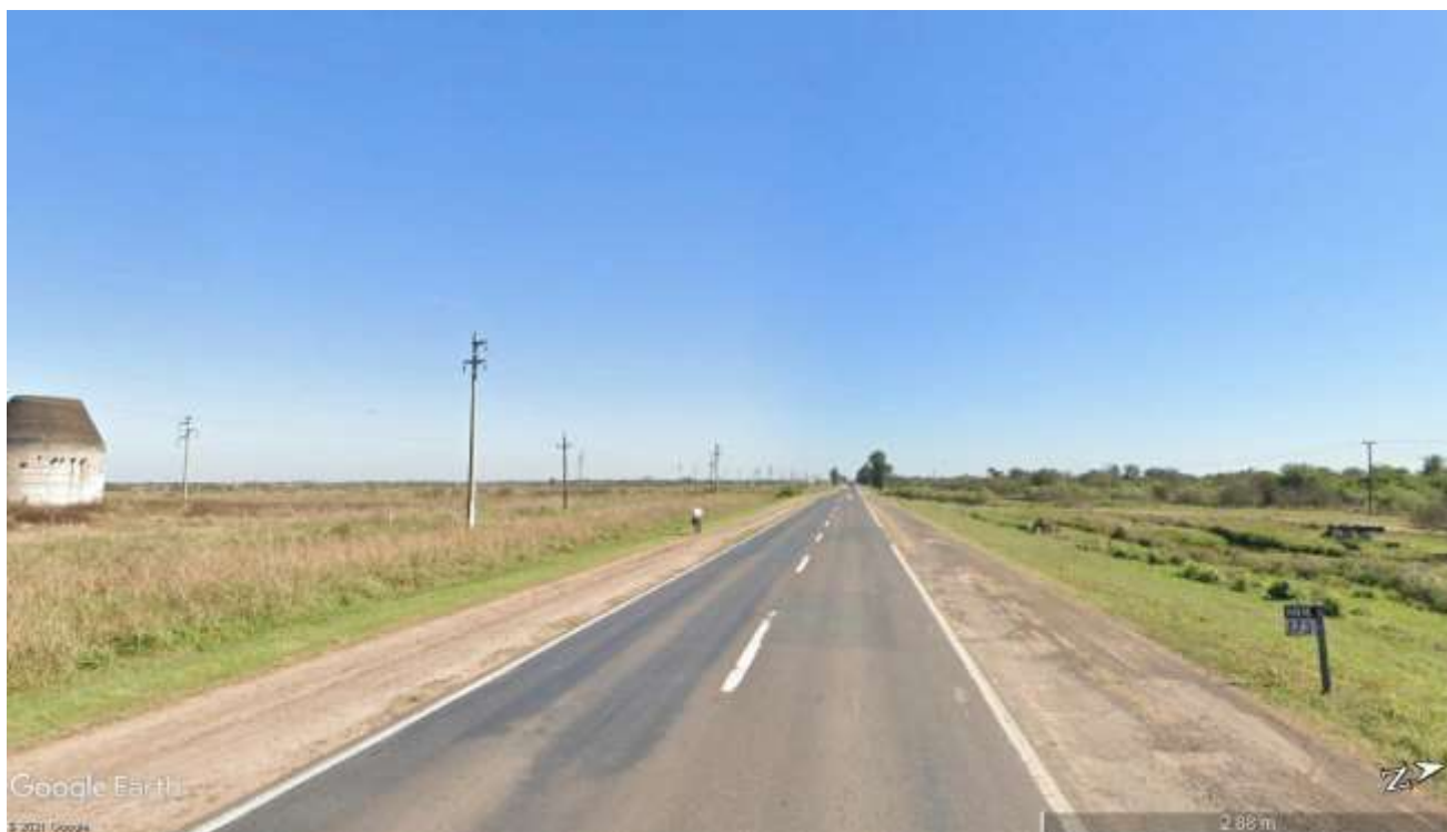
Imagen 3.2 – Vista de Banquinas RN N°16 Km 173,00 hacia el Noroeste
