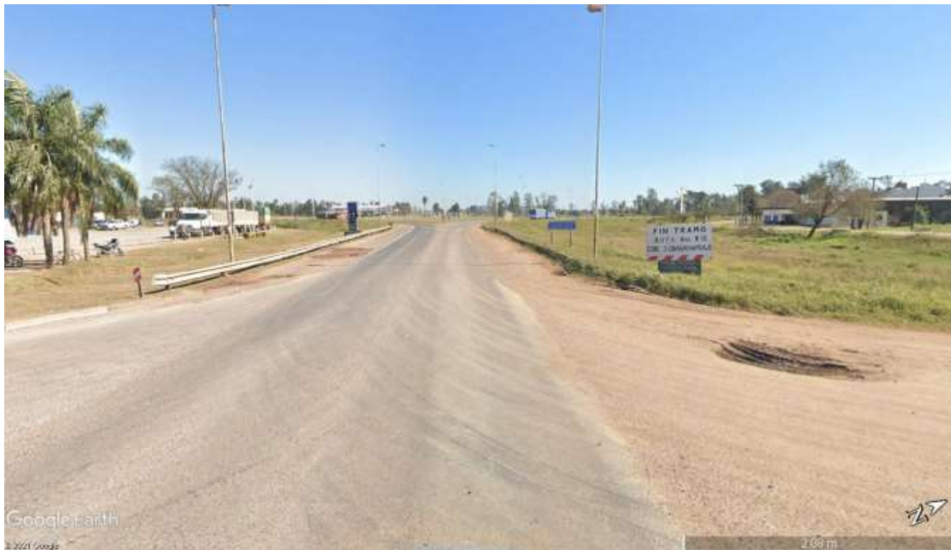
Imagen 3.2 – Vista de Banquinas RN N°16 Km 175,97 hacia el Noroeste
