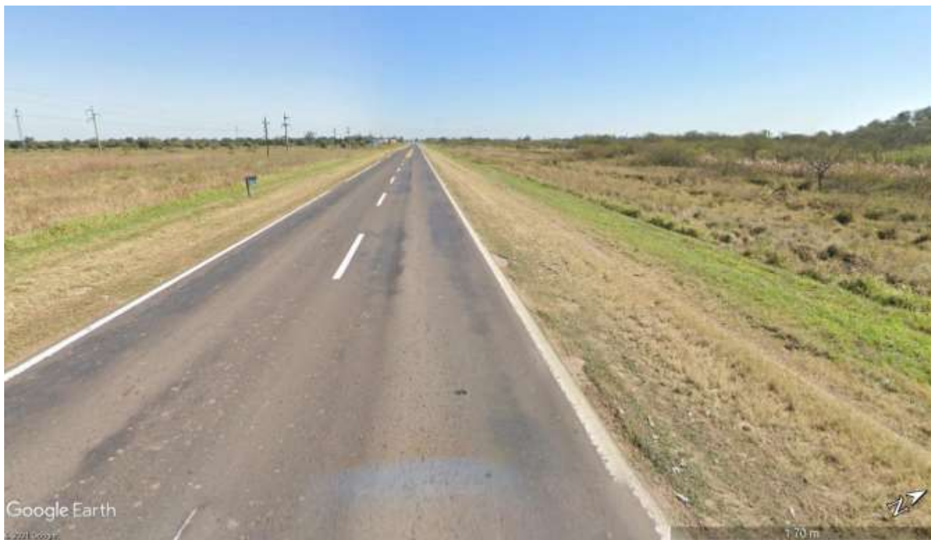
Imagen 3.2 – Vista de Banquinas RN N°16 Km 170,00 hacia el Noroeste
