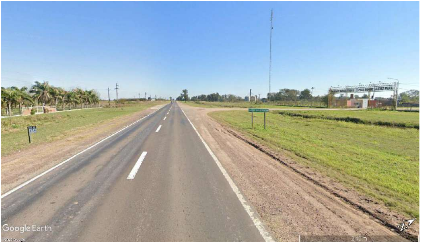
Imagen 3.2 – Vista de Banquinas RN N°16 Km 172,00 hacia el Noroeste
