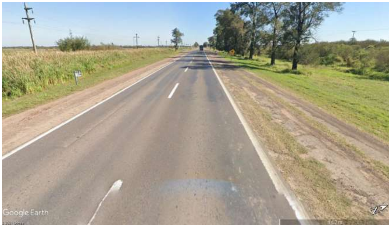
Imagen 3.2 – Vista de Banquinas RN N°16 Km 174,00 hacia el Noroeste
