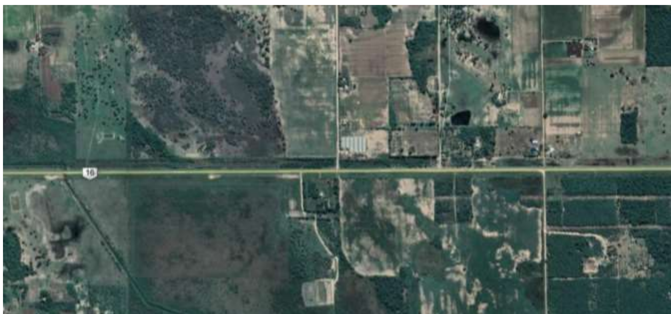
Imagen 2.5 – Imagen Aérea Banquinas RN N°16 – Km 168,00 a 170,80
