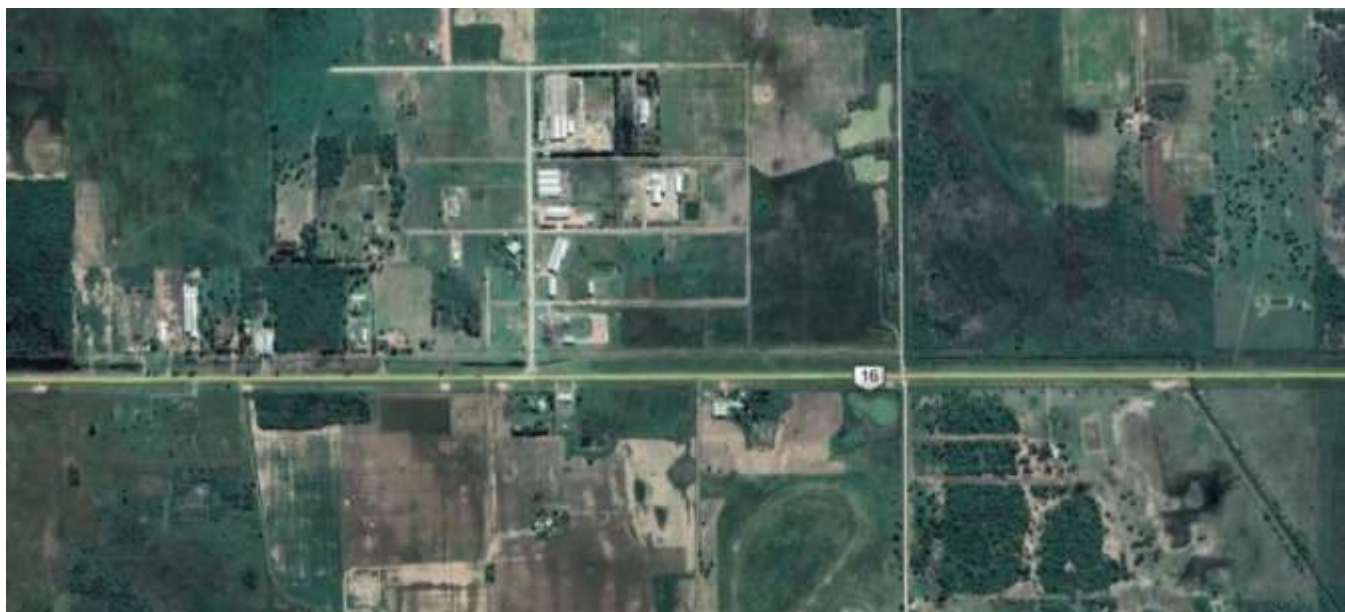
Imagen 2.4 – Imagen Aérea Banquinas RN N°16 – Km 170,80 a 173,40
