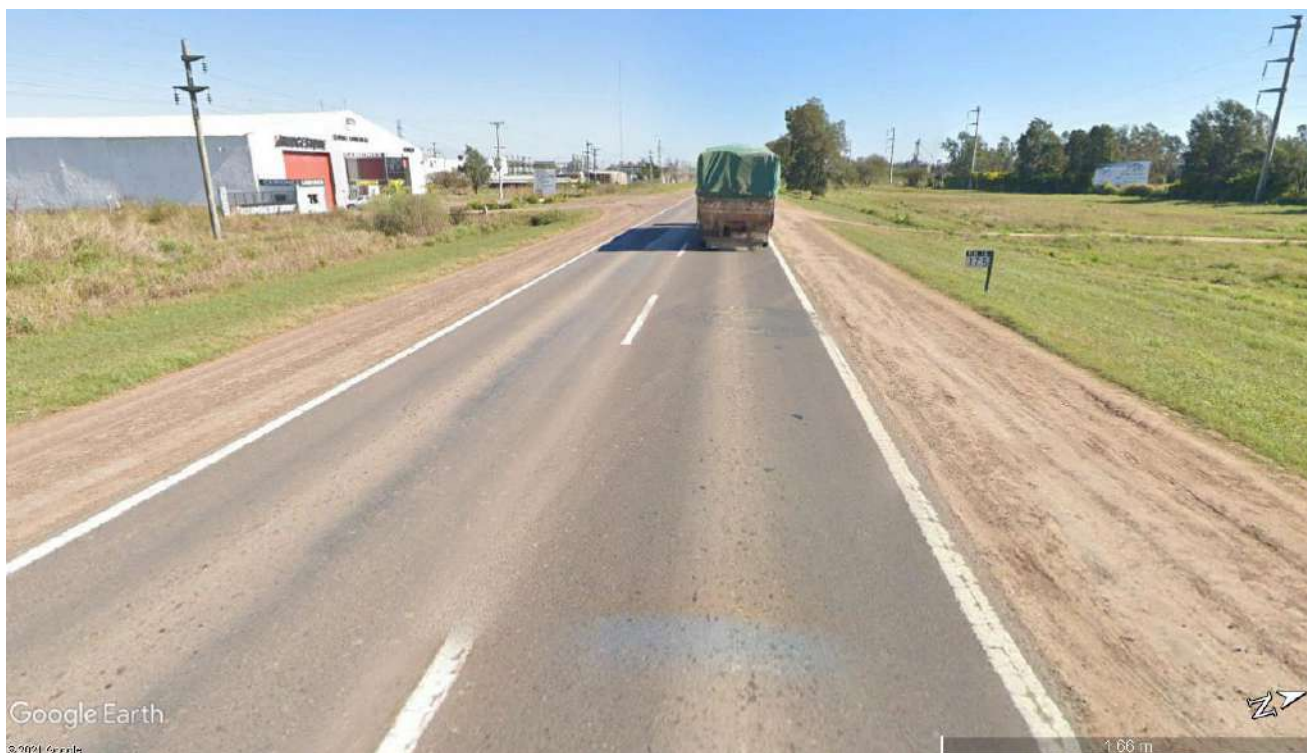
Imagen 3.2 – Vista de Banquinas RN N°16 Km 175,00 hacia el Noroeste
