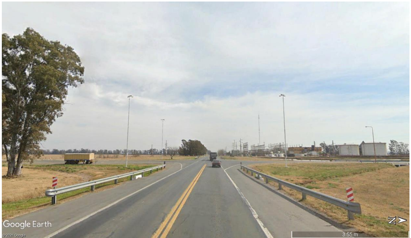
Imagen 3.1 – Vista de RN N°7 hacia el Oeste
