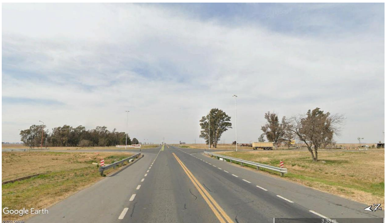
Imagen 3.2 – Vista de RN N°7 hacia el Este
