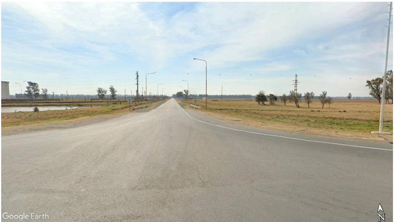
Imagen 3.3 – Vista de RP N°10 hacia el Norte (Acceso Gral. Levalle)
