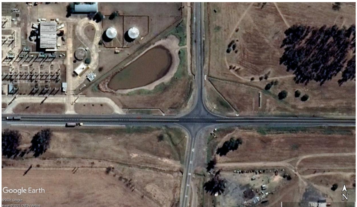
Imagen 2.3 – Imagen Aérea Intersección RN N°7 y RP N°10
