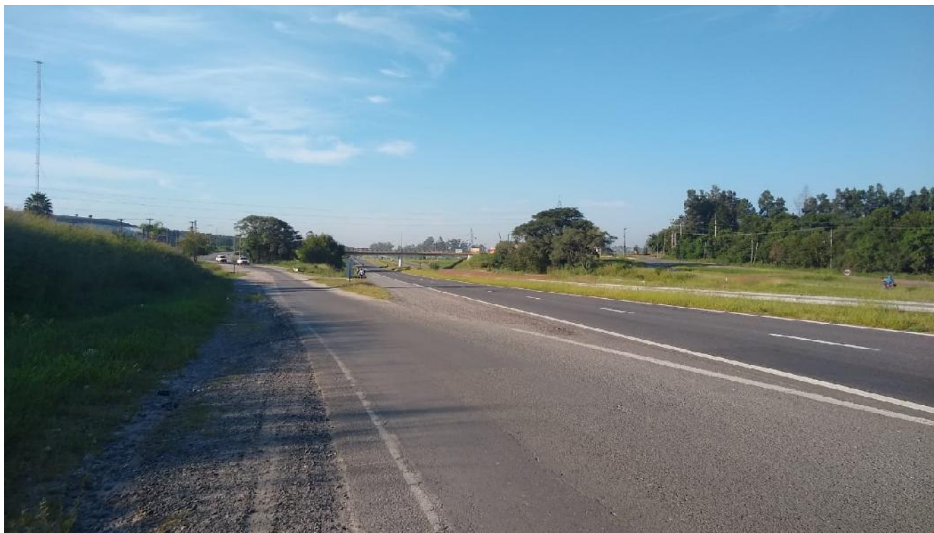
Imagen 3.11 – Vista hacia el norte sobre rama de ingreso a calzada descendente de RN N°9
