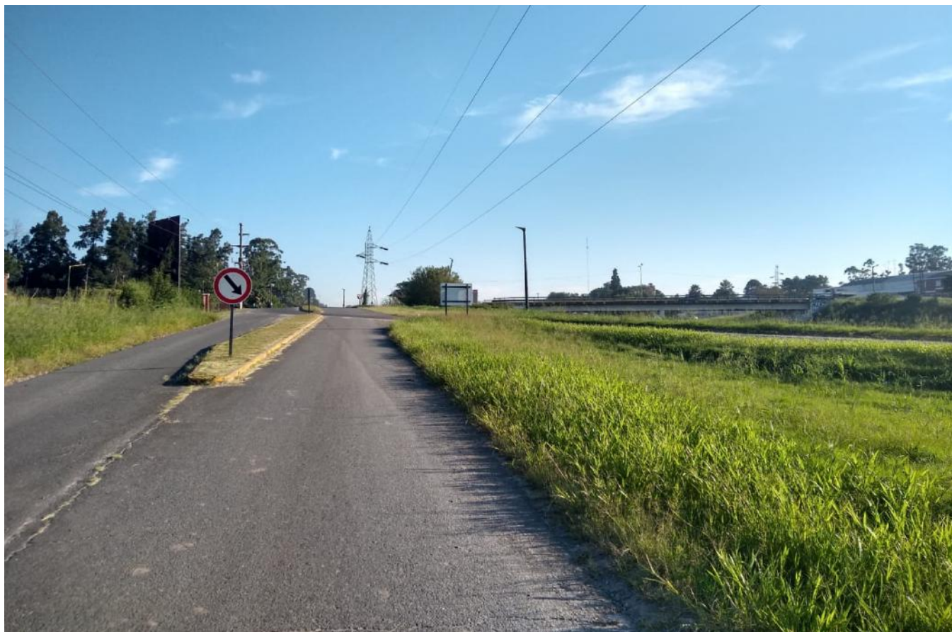
Imagen 3.10 – Vista hacia el norte de colectora lado Desc. y puente en Acceso a Tafí Viejo
