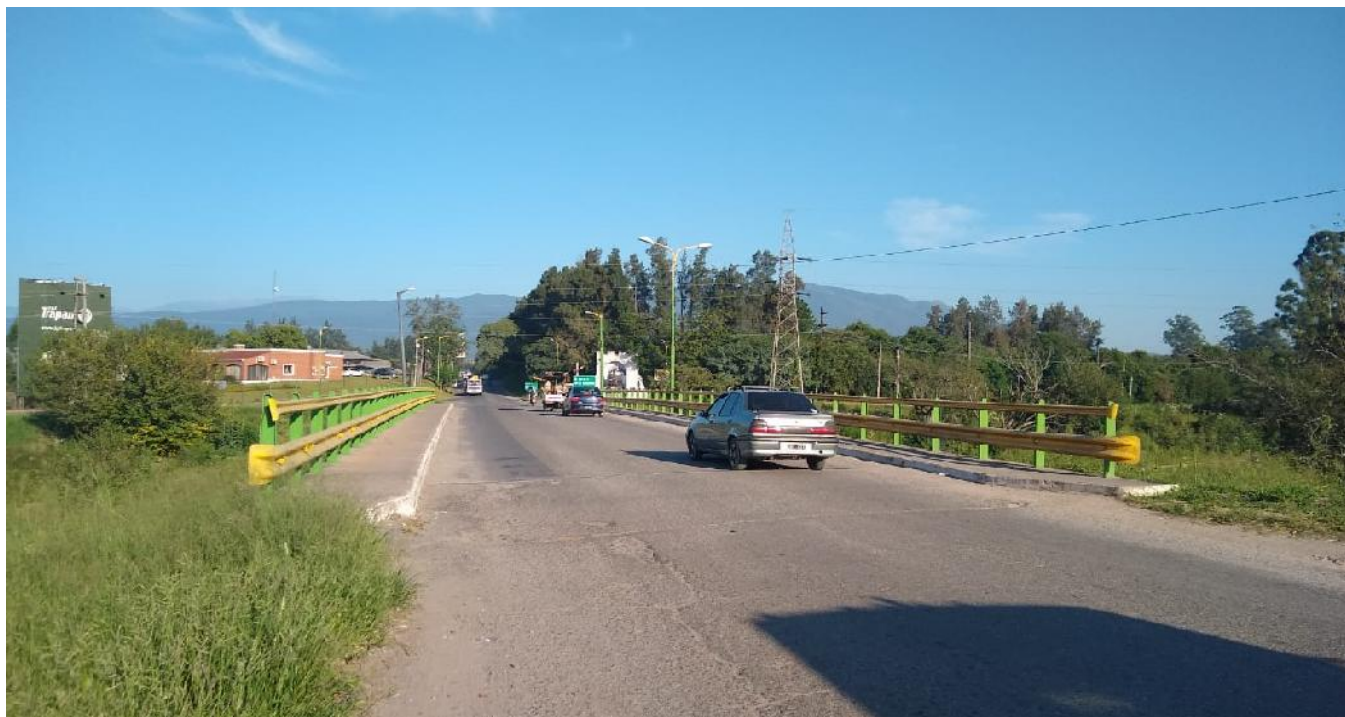
Imagen 3.7 – Vista de puente en Acceso a Tafí Viejo (hacia el Oeste)
