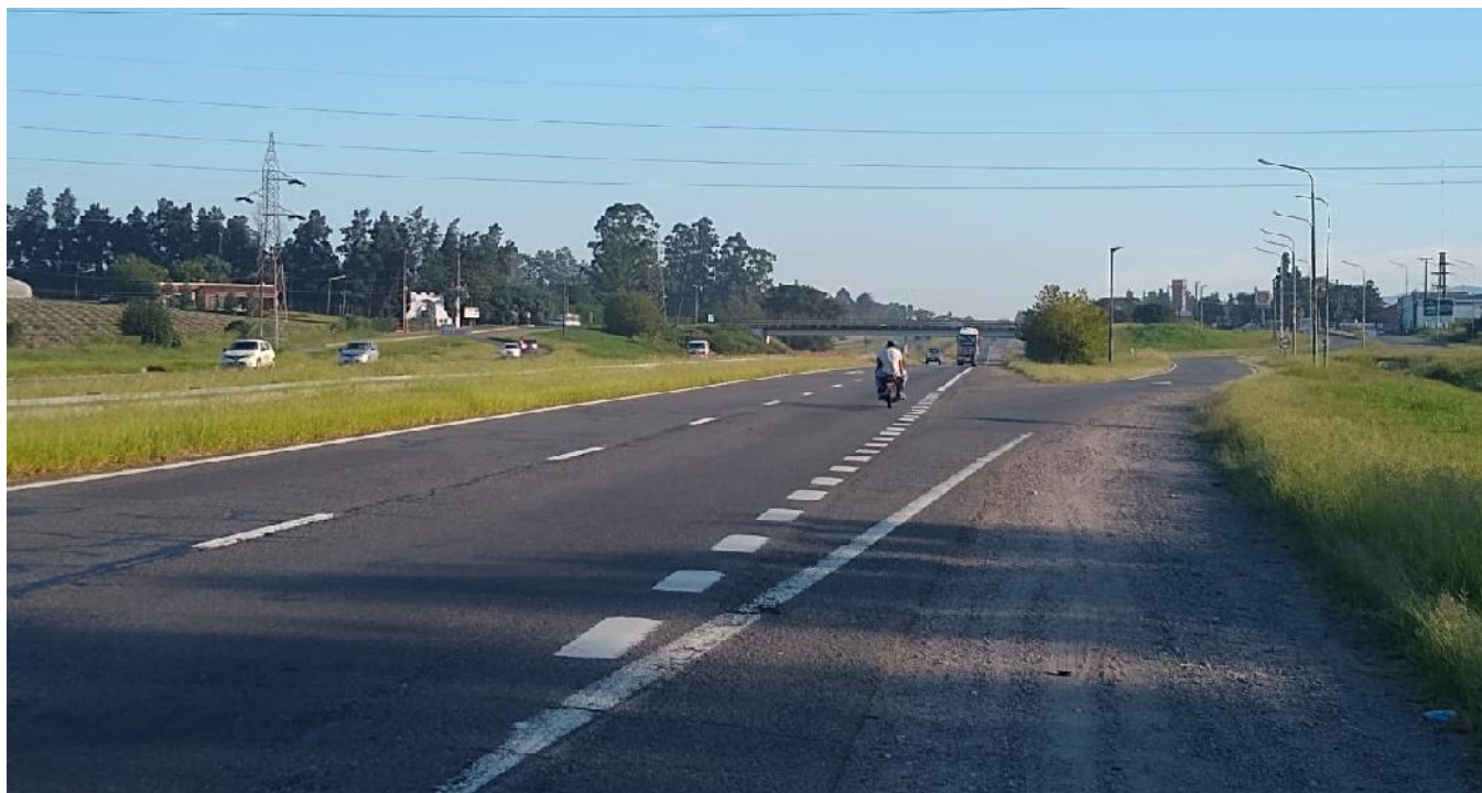
Imagen 3.2 – Vista de RNN°9 Calzada Asc y rama salida (hacia el Norte)
