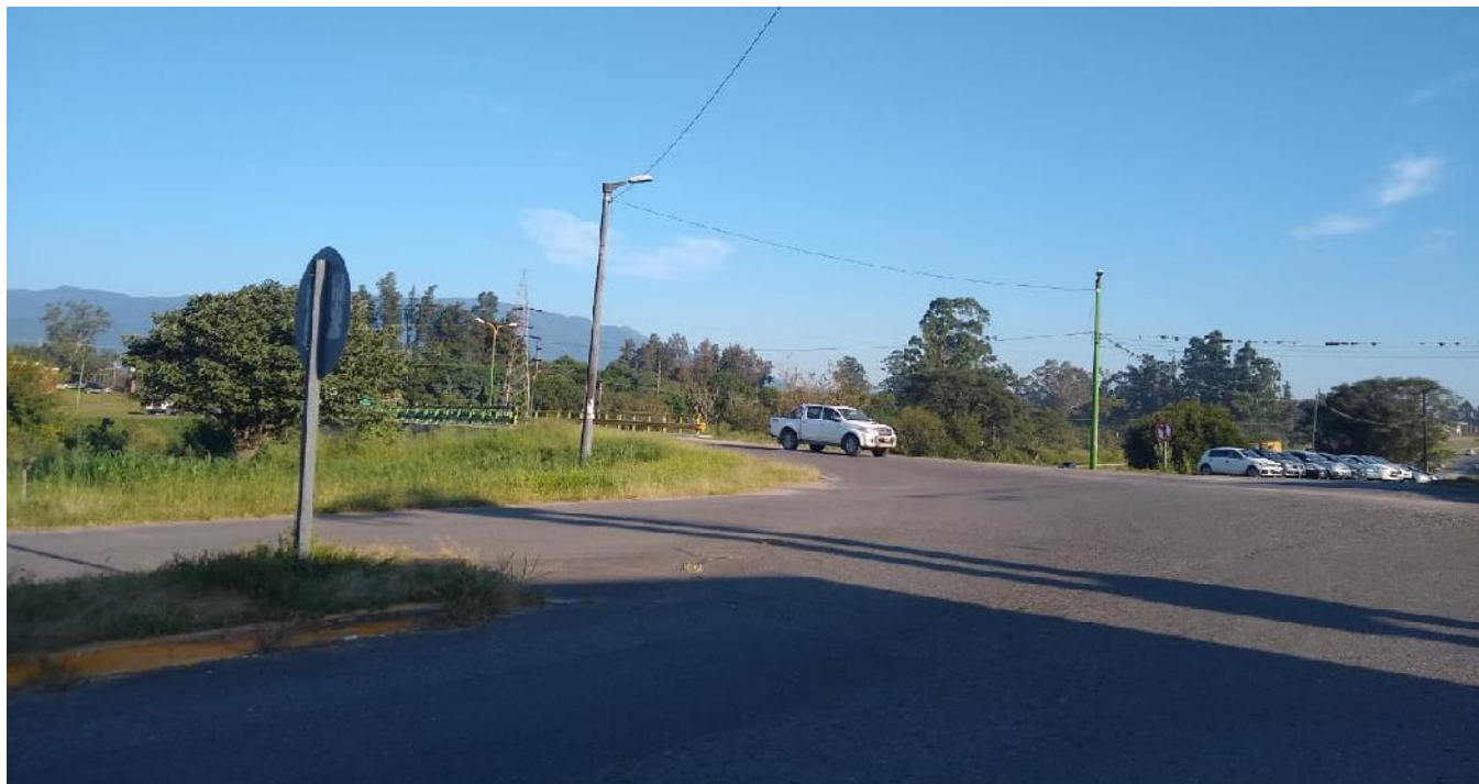
Imagen 3.6 – Vista de colectora Lado Asc y Puente en Acceso a Tafí Viejo
