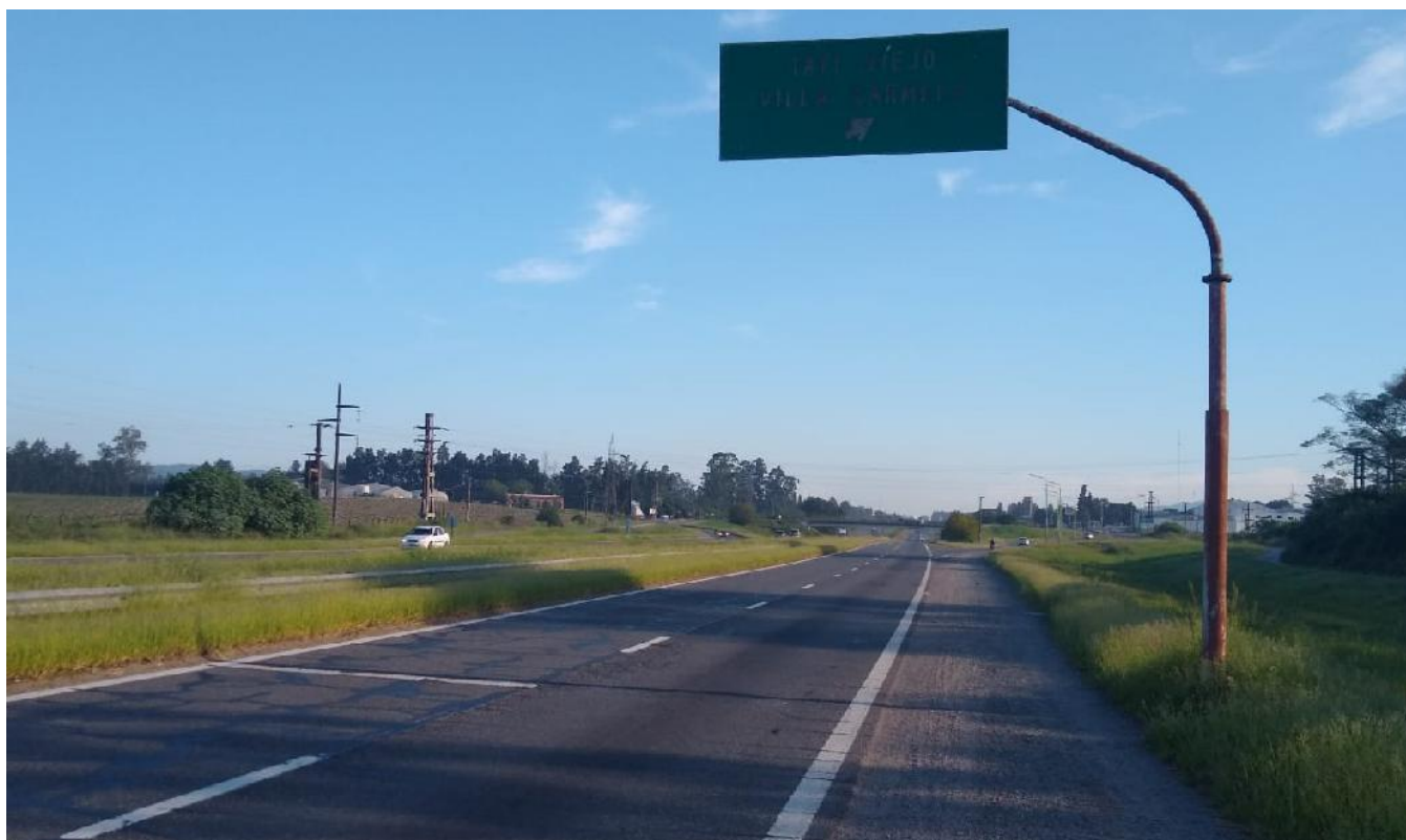
Imagen 3.1 – Vista de RNN°9 Calzada Asc hacia el Norte
