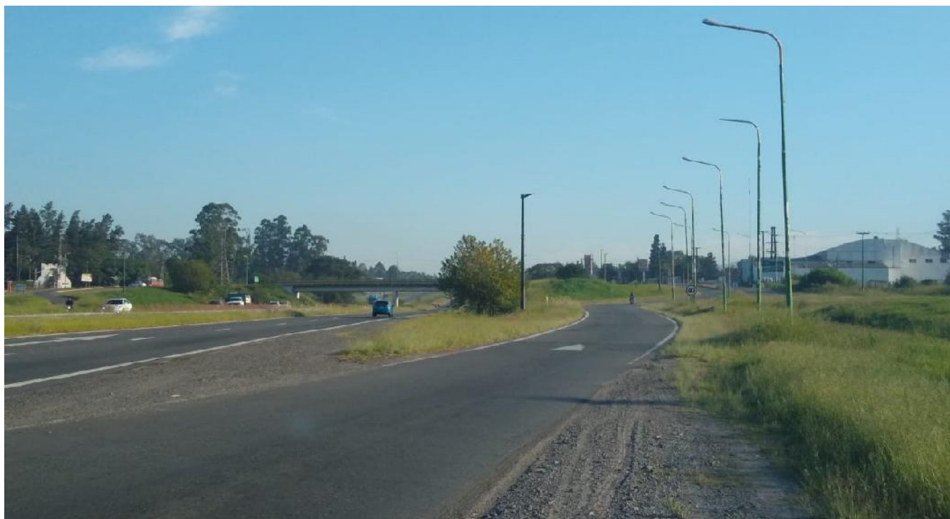
Imagen 3.3 – Vista de rama de salida RN N°9 (hacia el norte)
