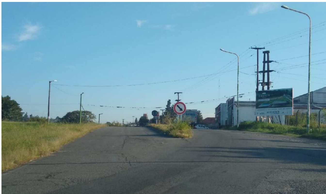
Imagen 3.5 – Vista de colectora Lado Asc en cercanías de Acceso a Tafí Viejo (hacia el Norte)
