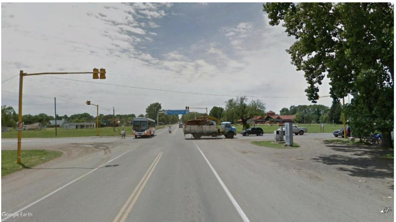
Imagen 10.8 – Vista de RN N°1V09 (hacia el Este) en intersección de RN N° A012
