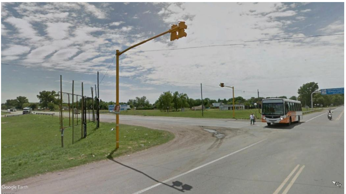
Imagen 10.14 – Vista de semáforos en intersección
