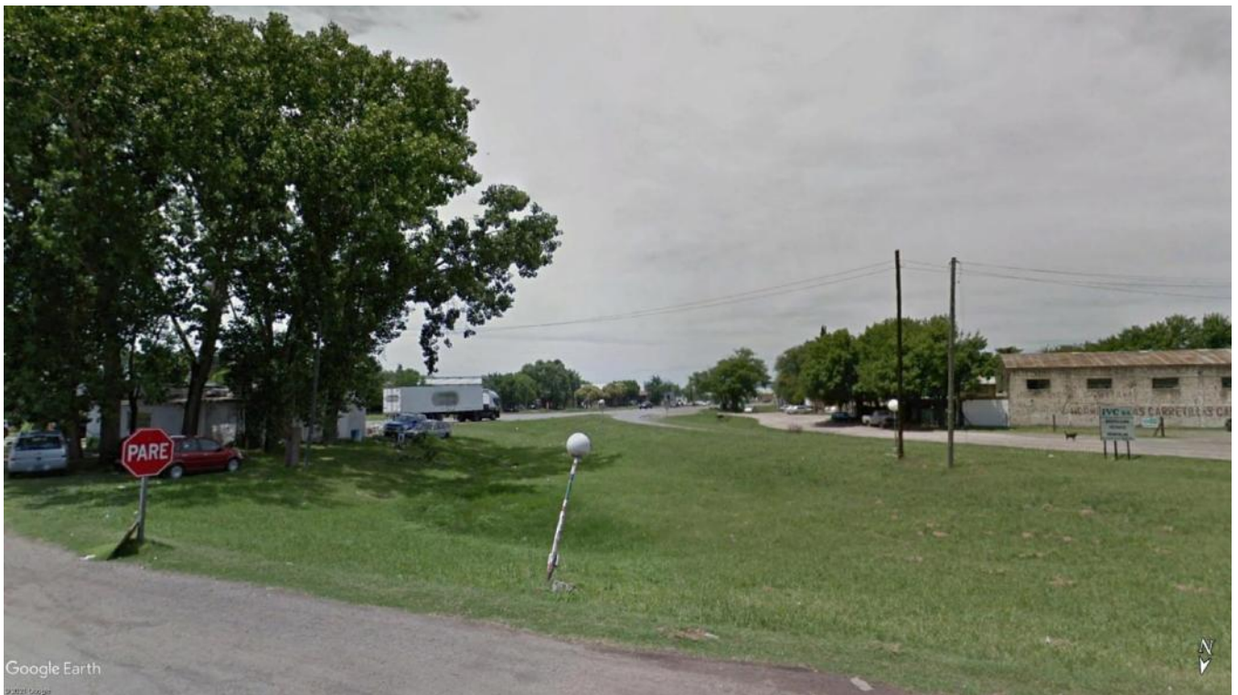
Imagen 10.13 – Vista de tendido aéreo en sector suroeste de la intersección
