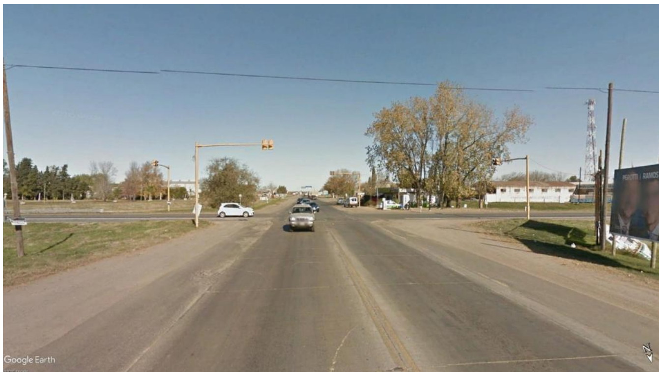
Imagen 10.1 – Vista de RN N° A012 (hacia el Sur) en intersección de RN N°1V09
