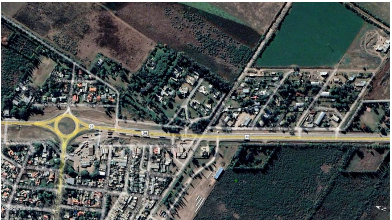
Imagen 2.4 – Imagen Aérea de la ubicación general de la obra en RNN°34 Km 259 a 260
