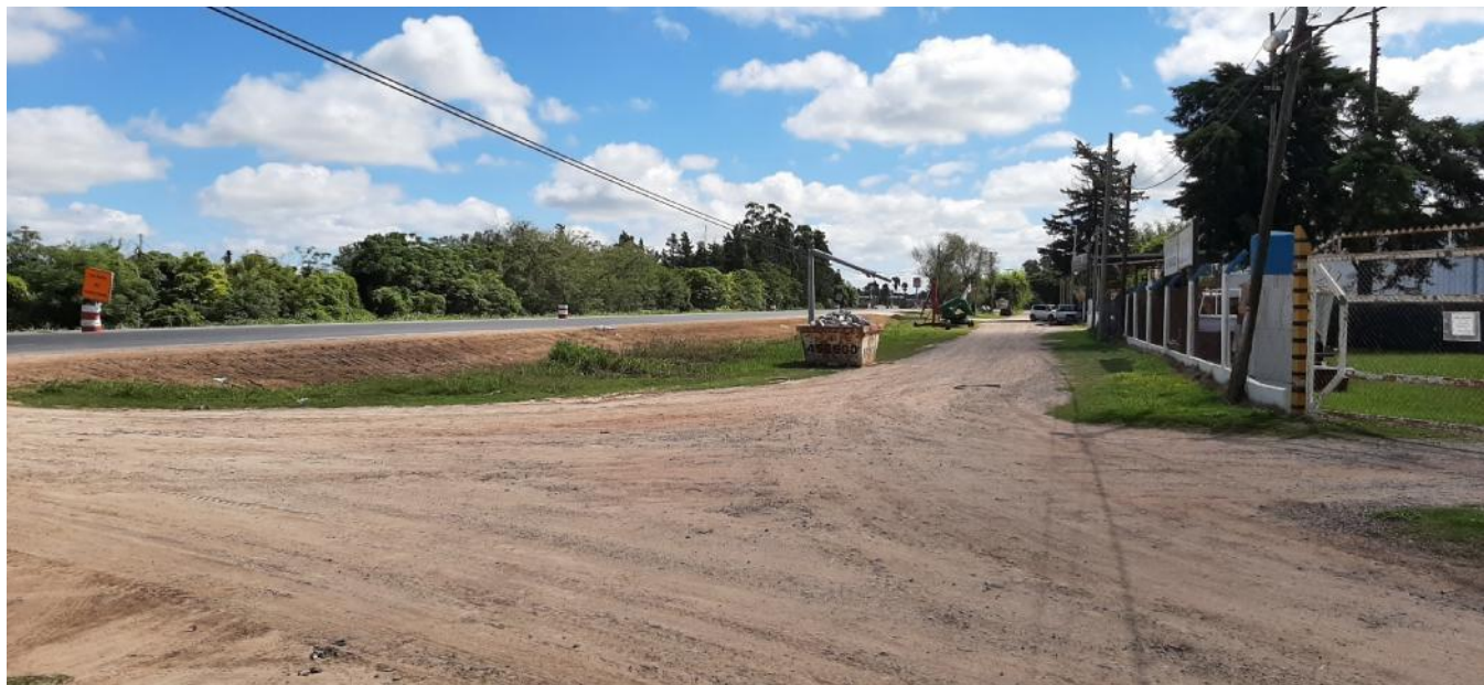
Imagen 10.7 – Calle Vicente Cipollati (final de obra) hacia el norte
