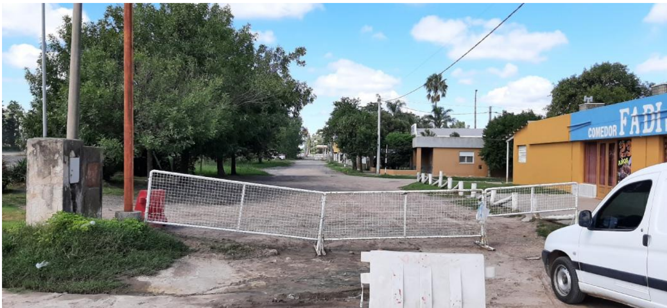
Imagen 10.3 – Calle Bolivia hacia el sur desde estación de servicio YPF
