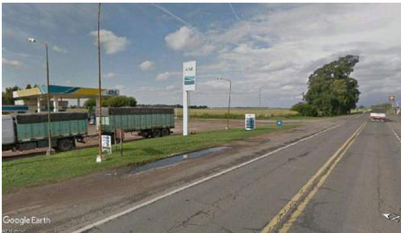
Imagen - Vista de luminarias y cartel a reubicar en Pk 431,65 Lado Asc
