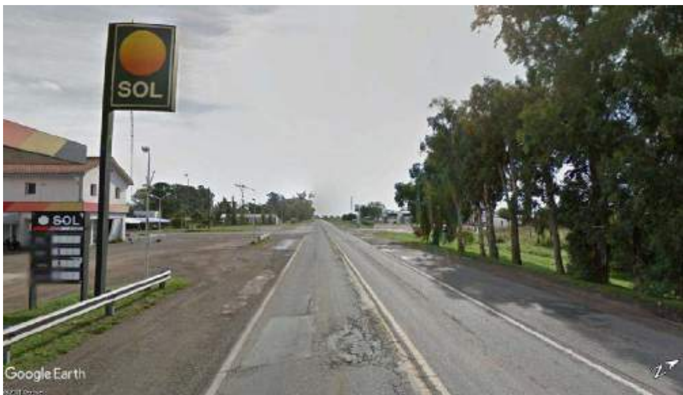
Imagen - Vista de RNN°8 hacia el oeste en Pk 431,50
