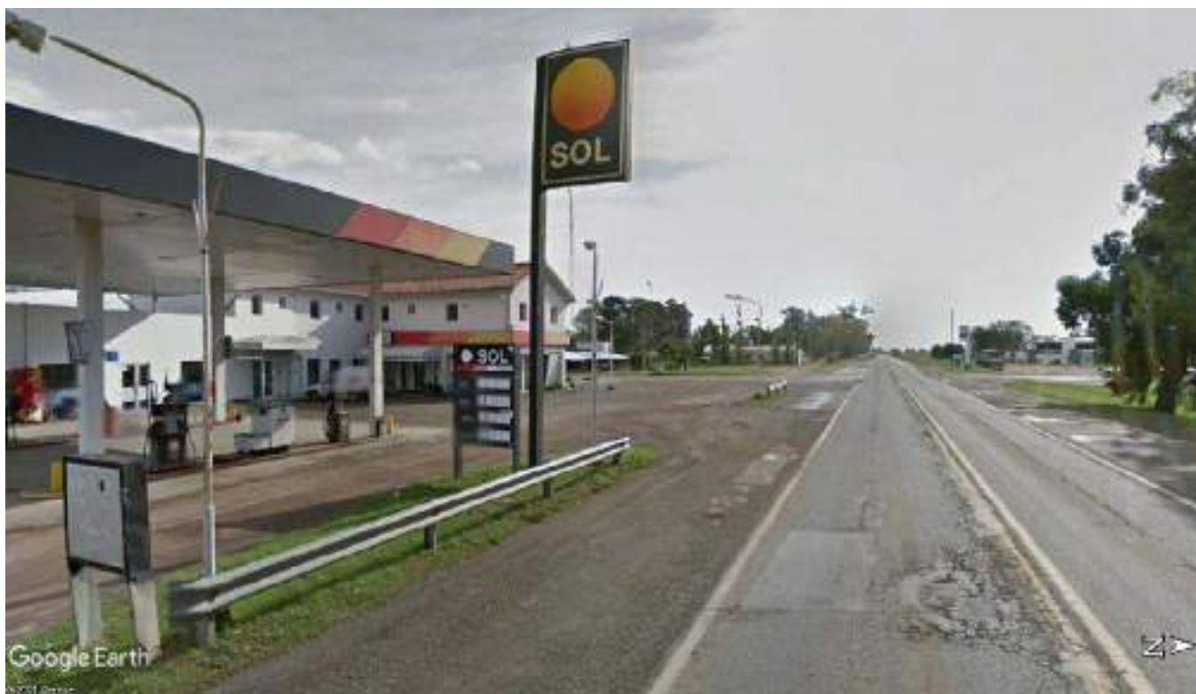
Imagen - Vista de luminarias y cartel a reubicar - defensa metálica a retirar Pk 431,5
