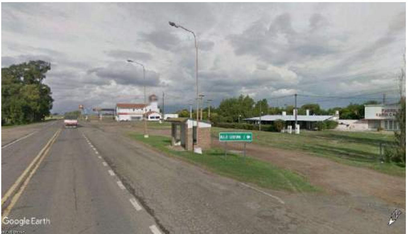
Imagen - Vista de Refugio de pasajeros y luminarias a reubicar en Pk 431,65
