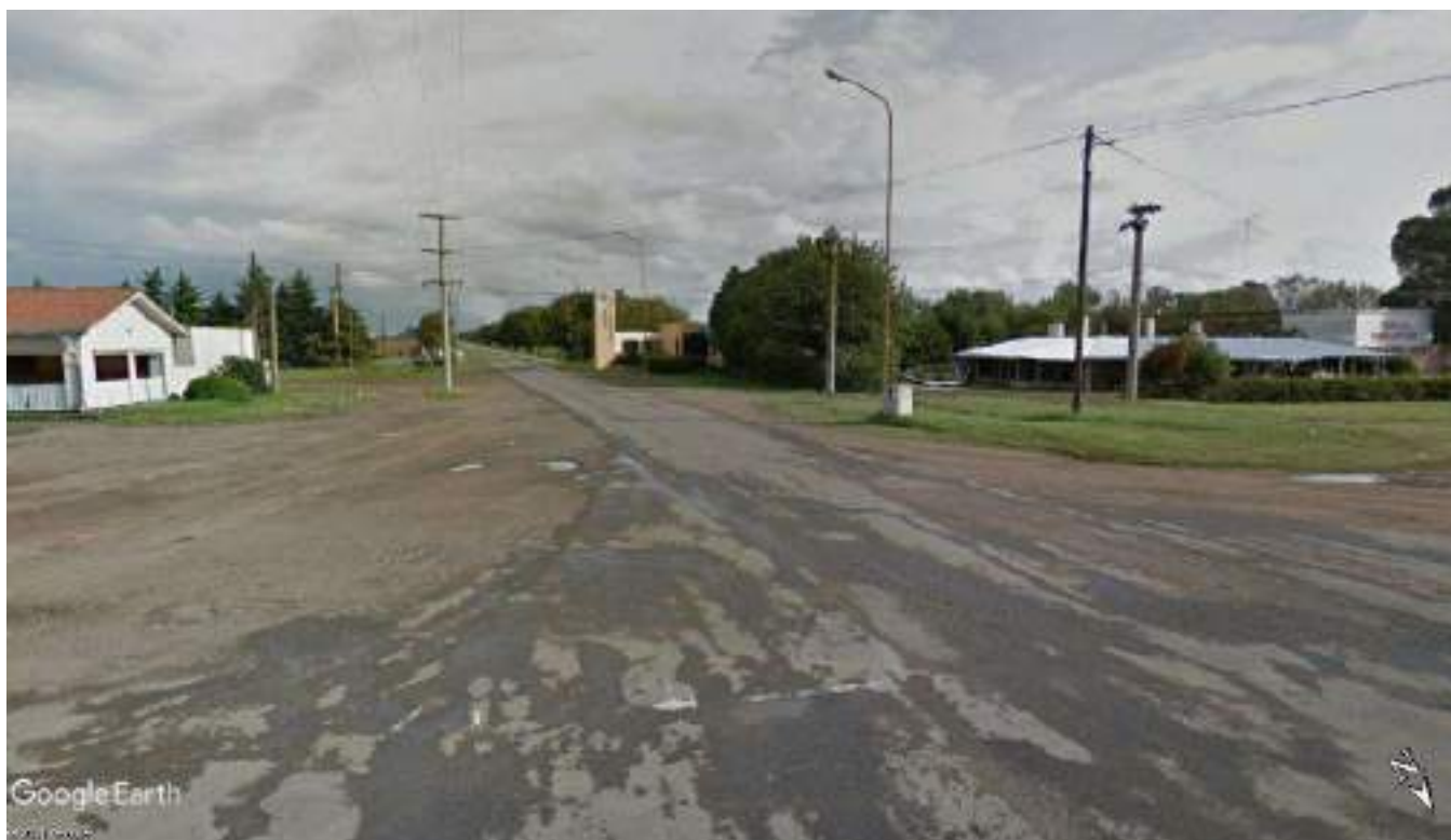
Imagen - Vista de Acceso a Alejo Ledesma – Luminaria y pilar a reubicar Pk 431,578
