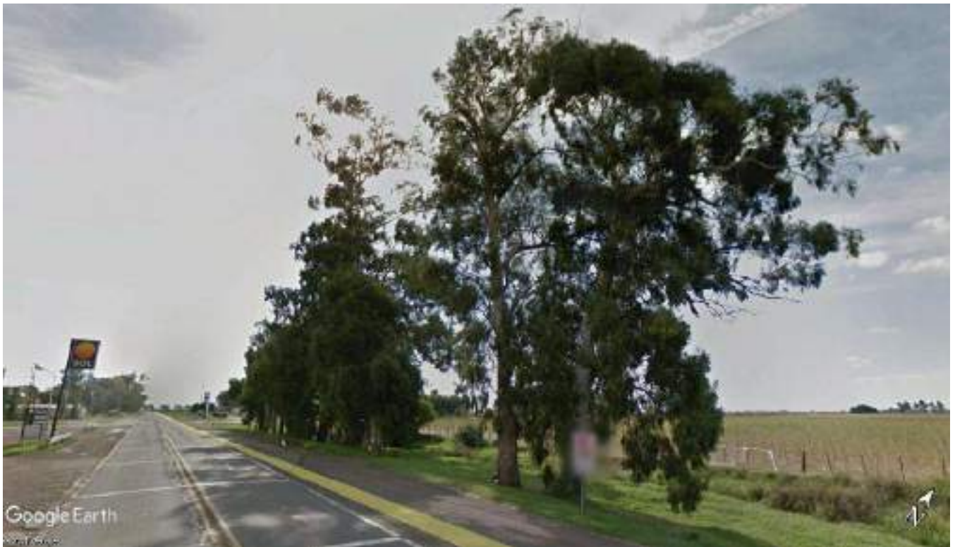
Imagen - Vista de RN N° 8 en sector de retiro de árboles Pk 431,50 Lado Asc
