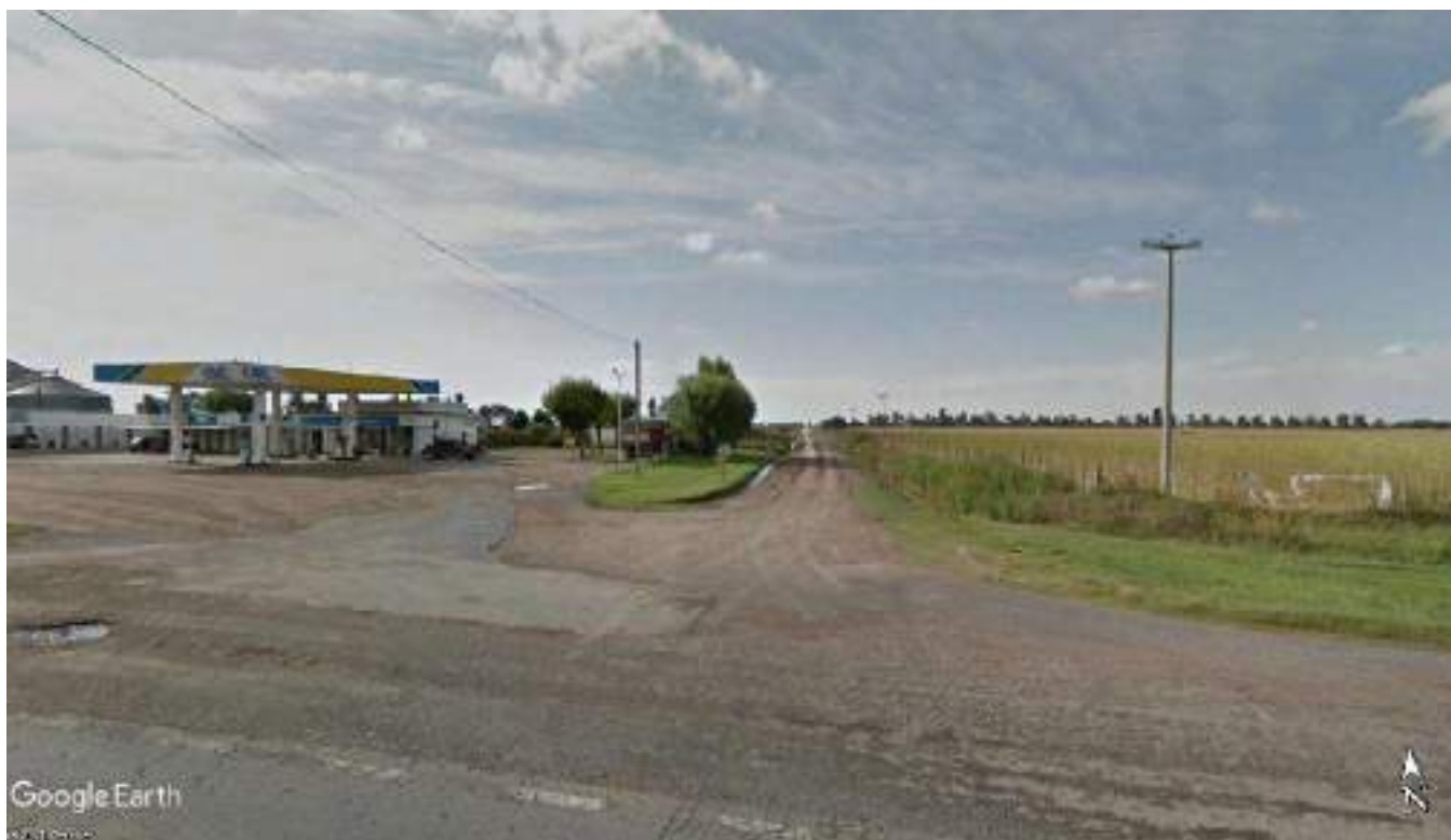
Imagen - Vista de calle en Pk 431,578 Lado Asc
